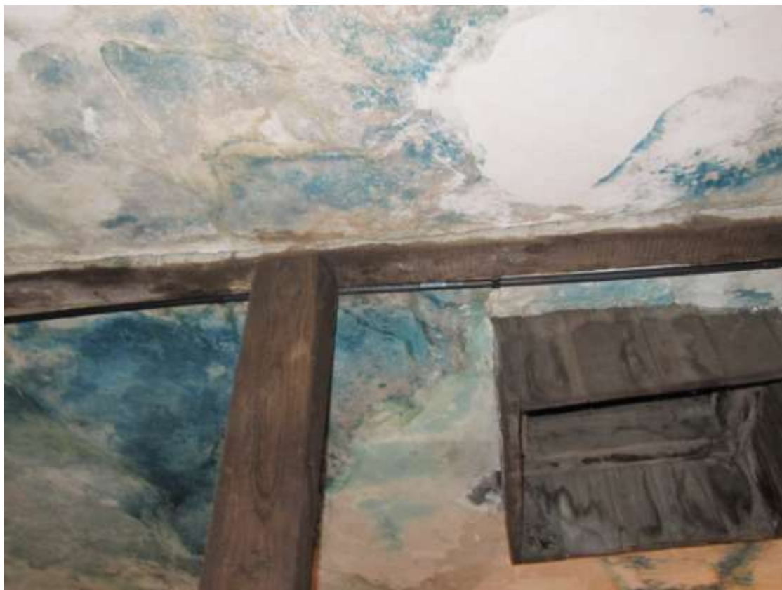
Fot. 12 Odształcenia tynków wybarwionych Cyklonem B
