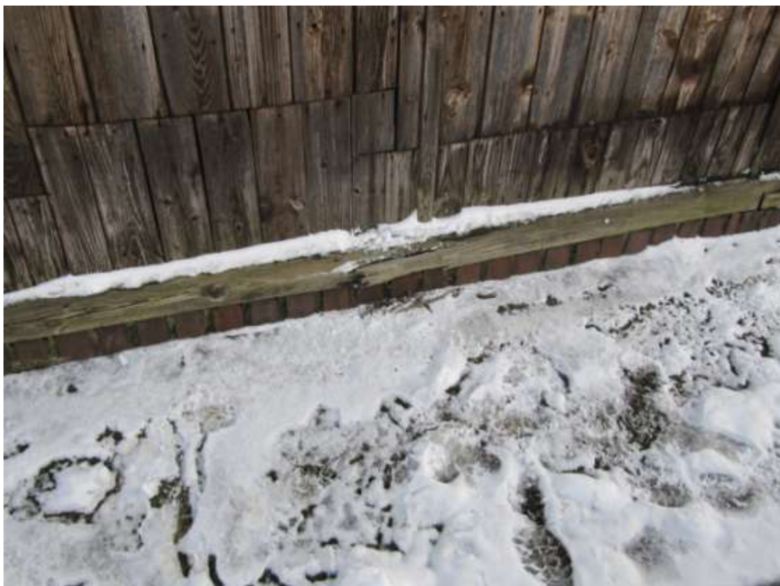
Fot. 6 Uszkodzenie podwalin w elewacji wschodniej
