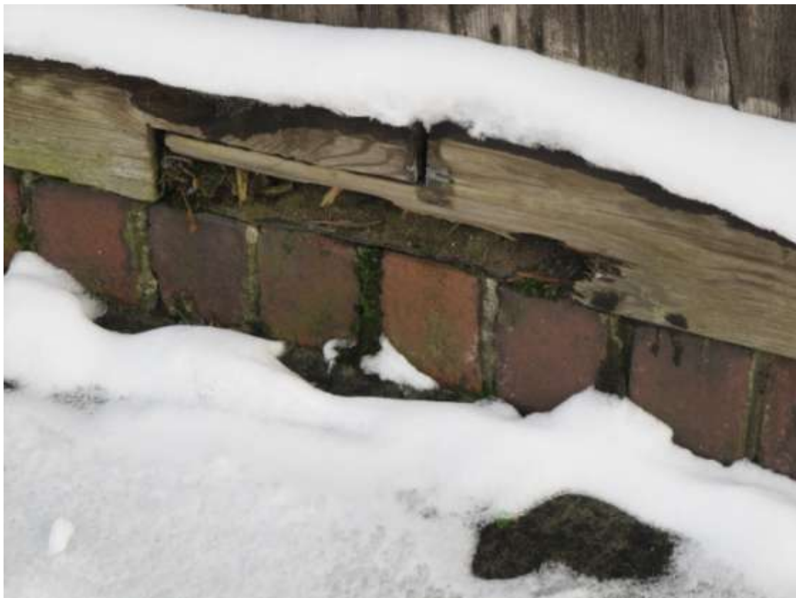
Fot. 8 Ubytek podwaliny w elewacji wschodniej
