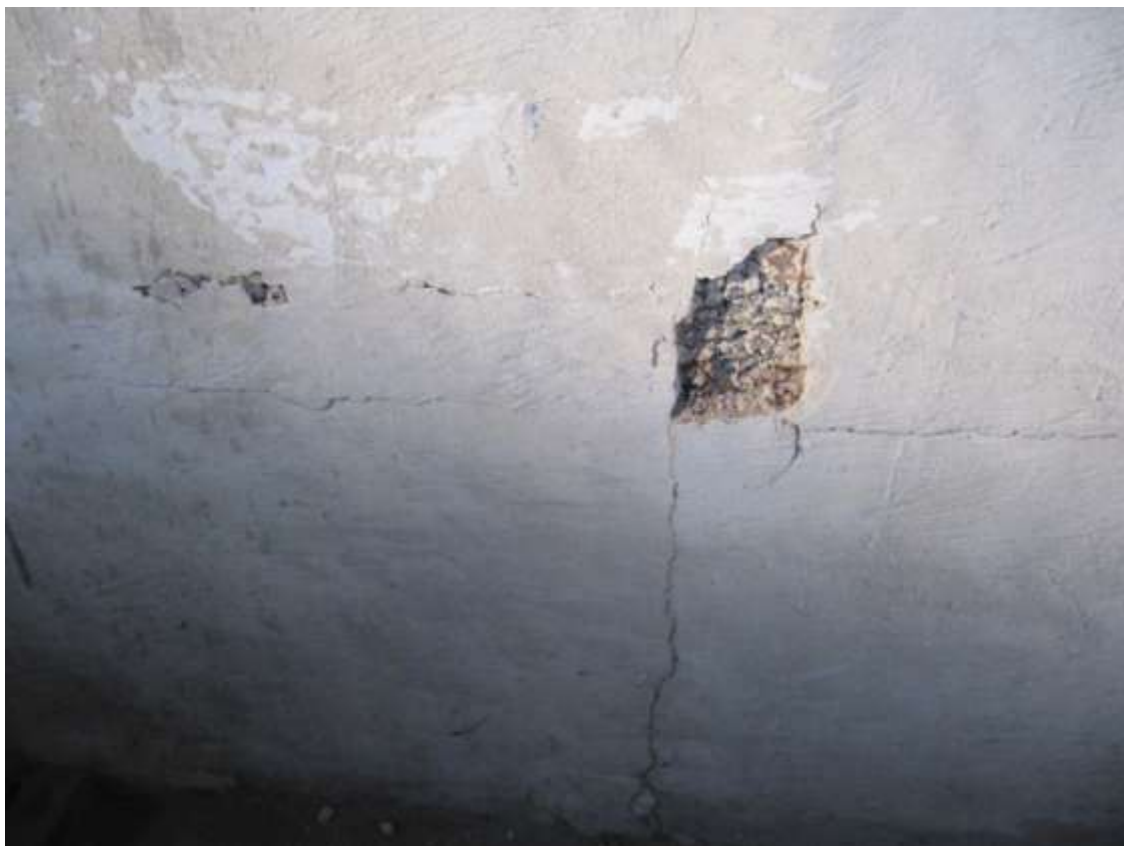
Fot. 10 Ubytki i zarysowania tynków w łaźni
