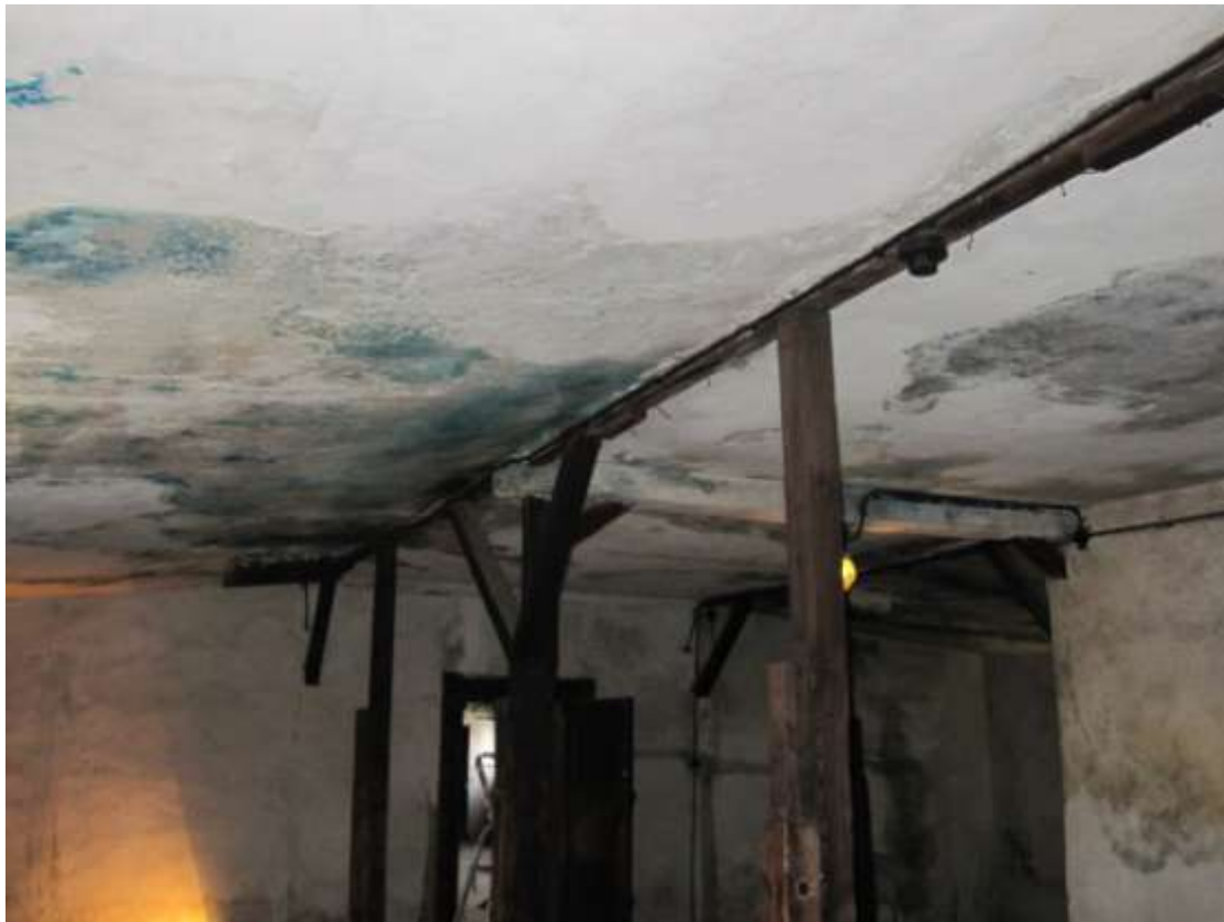
Fot. 12 Odształcenia tynków wybarwionych Cyklonem B
