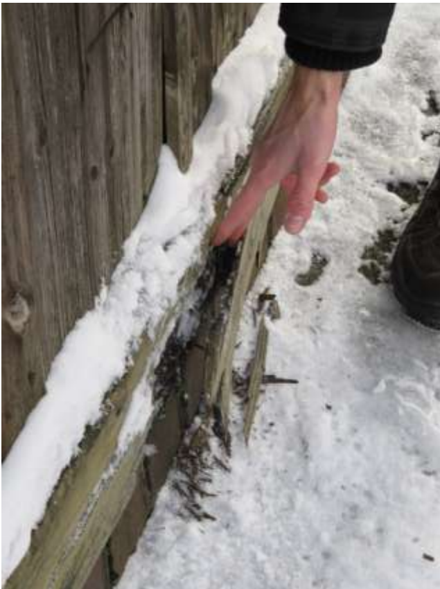
Fot. 8 Ubytek podwaliny w elewacji wschodniej
