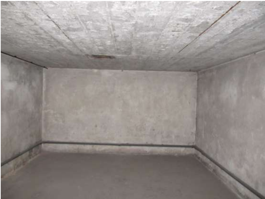
Fot. 23 Widok komory gazowej zach
